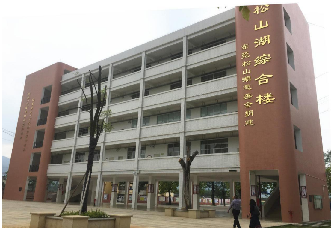
松山湖综合楼
